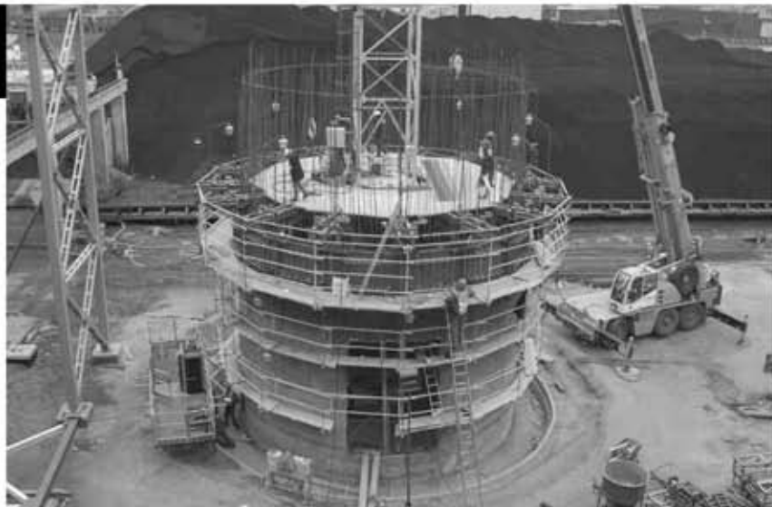
Pierwsze dni budowy kominu w Ec Siekierki, listopad 2008r.
